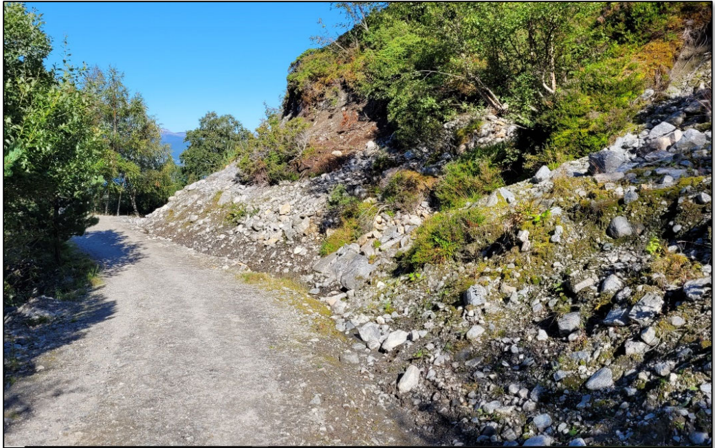
Foto frå «Vonløypa» nedanfor «Bukkane Bruse-brua»/ Gamlestølen – viser lausmasseskråningar til dels utan vegetasjon. Skjeringsfot bør sikrast med tørrmur i naturstein.
