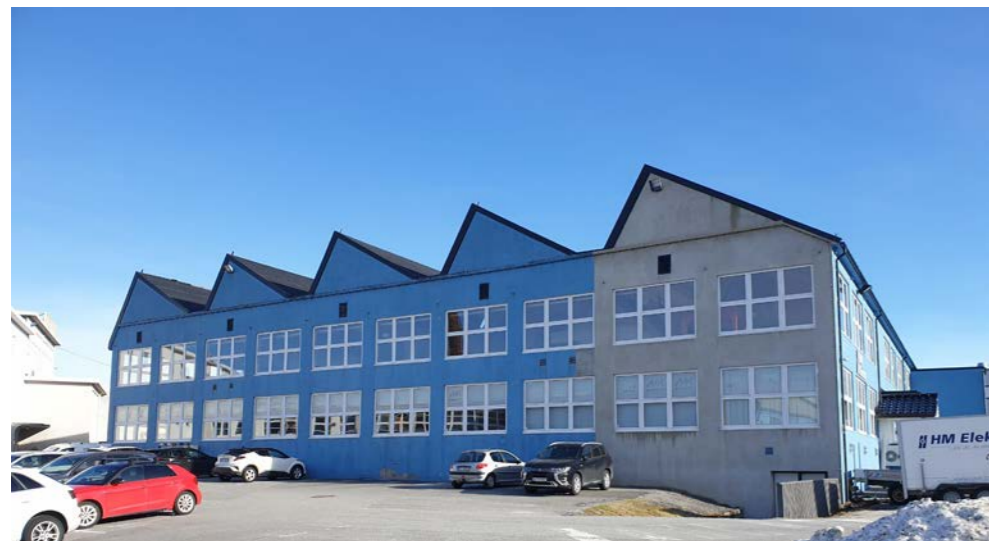
Saksebygget har et karakteristisk tak med en tydelig markert gesims.
