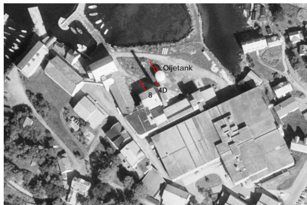
Flyfoto ifra 1975 hentet fra norgebilder.no som viser den gamle oljetanken Røde linjer er trekt opp for å sammenligne skyggene
