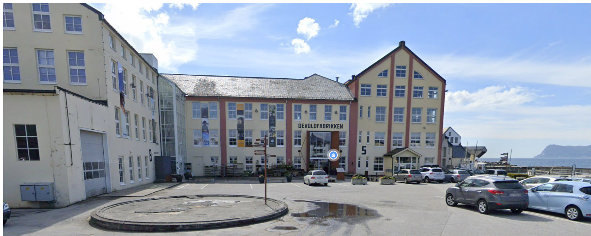
Bilde hentet ifra Google Street View. Viser fasaden på Bygg 5, Bygg 8 og Bygg 4D og fundamentet til den gamle oljetanken
