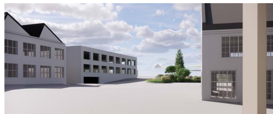
Parkeringshuset sett fra Bygg 1
